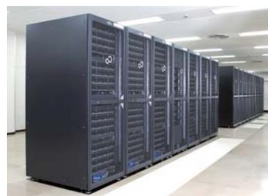
搬手前のラック群は演算サーバで、全部で368台、5888CPUコアのPCサーバです。奥のラック群はファイルサーバなどの運用系のサーバで、半分以上ディスクが占めています。
