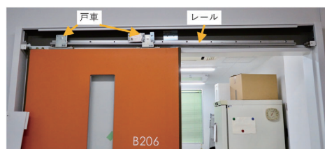
図2 扉は上方から吊られている構造
