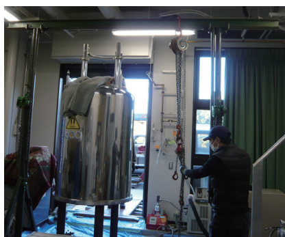
写真2 マグネットの搬出 (専用治具を組み立ててマグネットを吊り下げて扉付近まで移動させた後、クレーン車へ積み込み)
