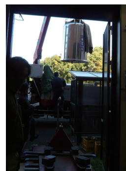
写真2 マグネットの搬出 (専用治具を組み立ててマグネットを吊り下げて扉付近まで移動させた後、クレーン車へ積み込み)
